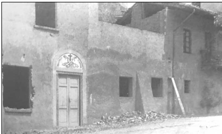
La porticina d'ingresso alla piccola cappella dalla piazzetta esterna poco prima della demolizione
